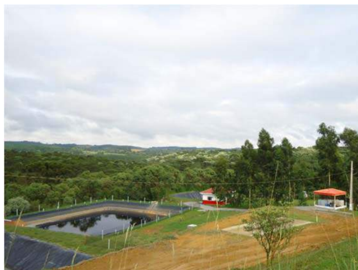
Figura 126: Vista Superior do Local de Tratamento do Chorume
