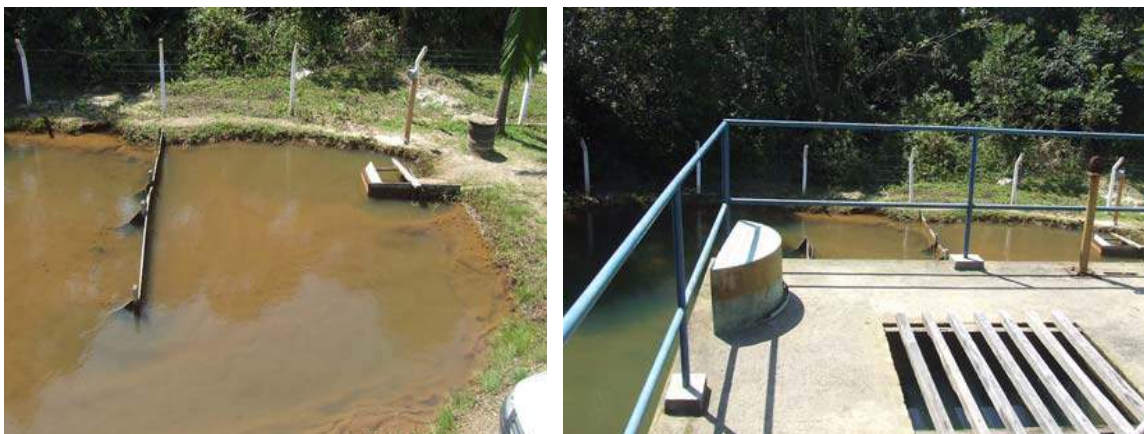
Figura 67: Lagoa de Decantação – ETA Secundária
