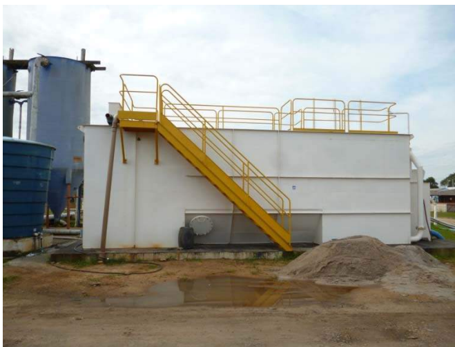
Figura 58: ETA Compacta – 50 m 3 /hora
