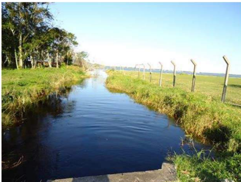
Figura 170: Canal a Jusante do Bueiro com Maré Alta
