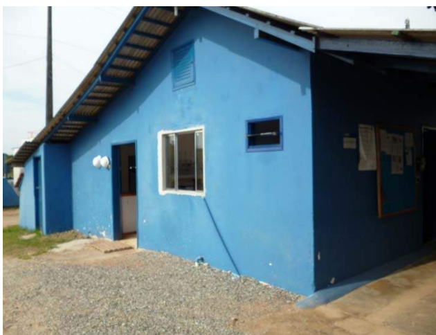
Figura 61: Vista Geral do Almojarifado da ETA Principal
