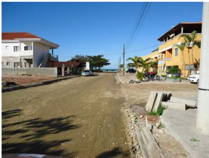
Figura 191: Obras de Drenagem e Pavimentação na Rua 960
