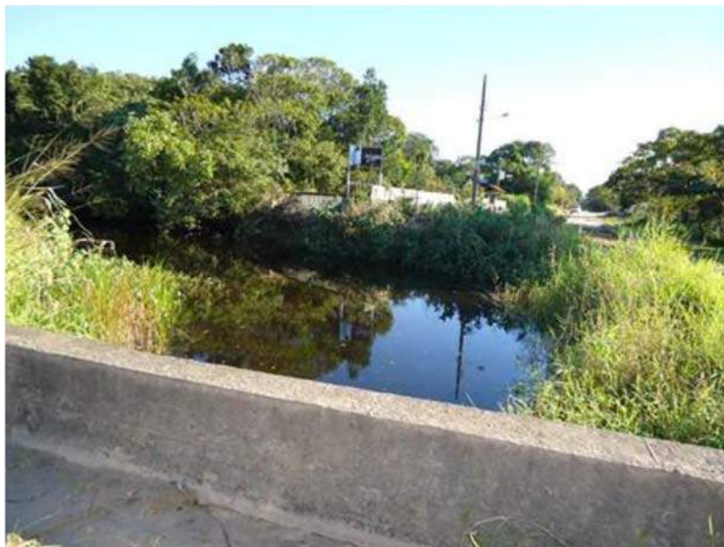
Figura 165: Bueiro Rio Gracioso
