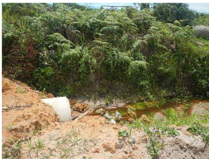
Figura 86: Destinação Irregular de Efluentes Domésticos
