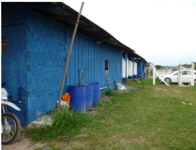
Figura 55: Vista Geral das Edificações da ETA Principal
