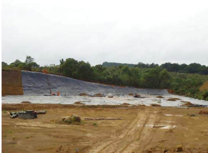
Figura 124: Vista Geral do Aterro Sanitário
