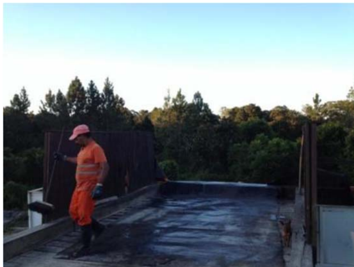
Figura 136: Rampa sob Manta Geotêxtil
