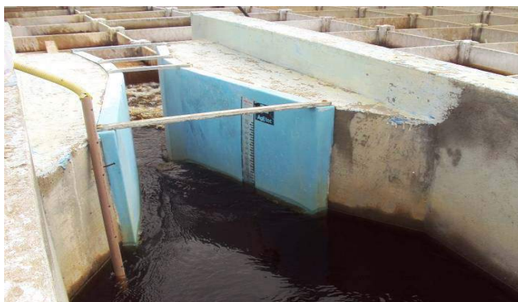
Figura 37: Calha Parshall
