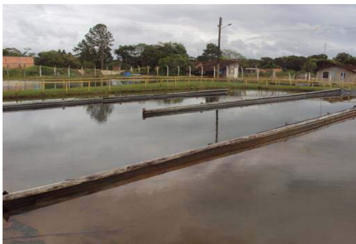
Figura 41: Vista Geral das Lagoas de Decantação
