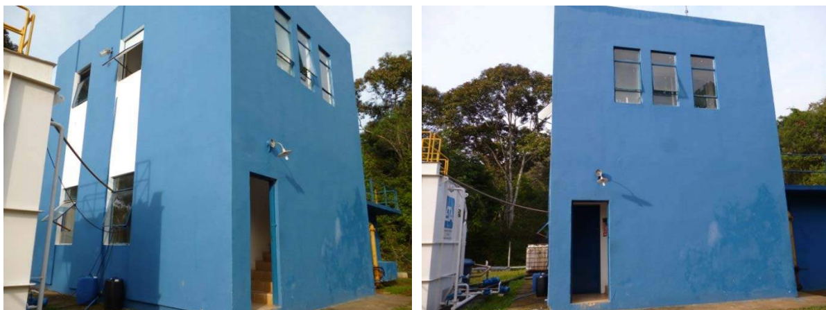
Figura 71: Vista Geral das instalações da ETA Secundária, Após a Concessão
