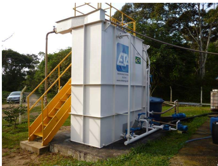
Figura 73: ETA Compacta – 5m 3 /hora
