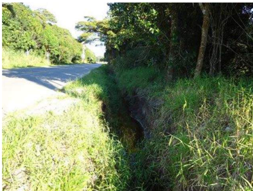
Figura 166: Vala na Av. Brasil próximo a Rua 2.080
