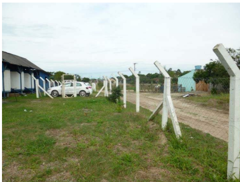
Figura 54: Vista Geral do Fechamento da Área da ETA Principal
