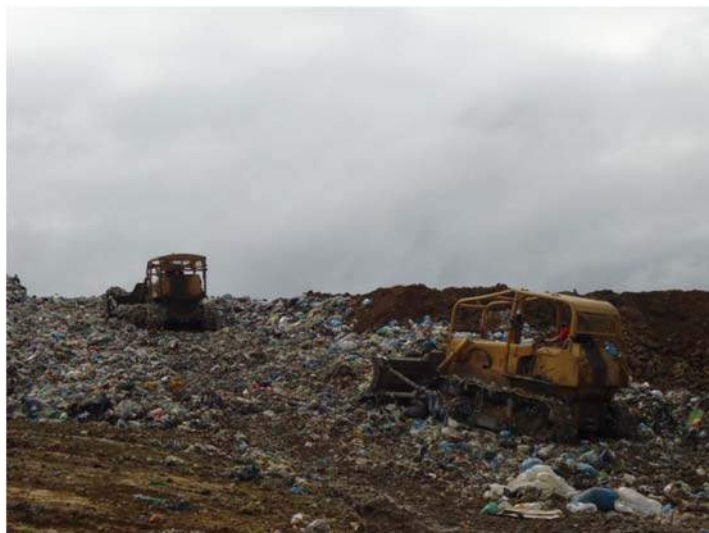
Figura 125: Frente de Serviço do Aterro
