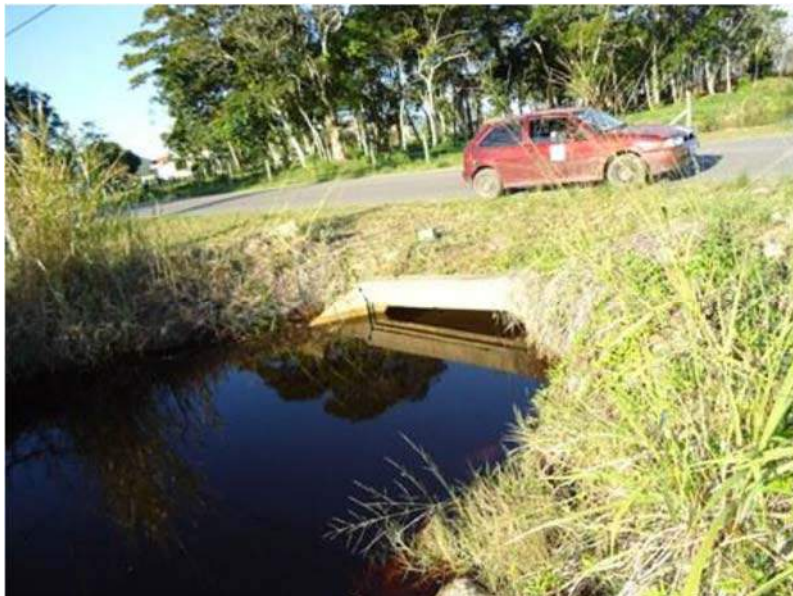
Figura 169: Bueiro sob a Avenida Beira Mar 05
