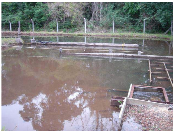
Figura 68: Lagoa de Decantação
