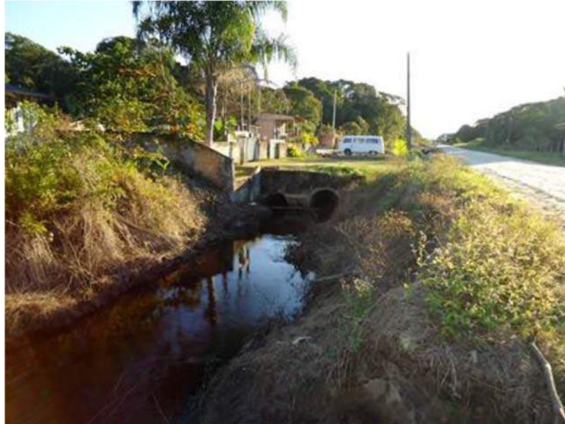
Figura 156: Desvio Parcial do Rio Mendanha pela Rua 1.310
