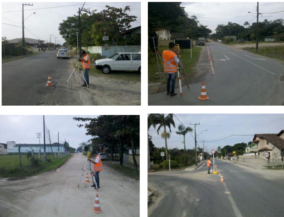
Figura 87: Execução de Serviços Topográficos para a Elaboração de Projetos
