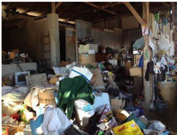
Figura 138: Interior da Edificação da Unidade de Triagem
