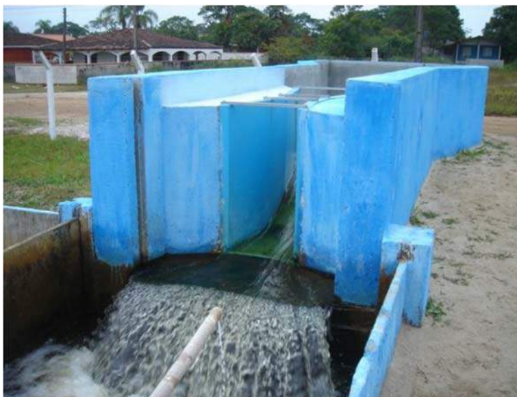
Figura 38: Calha Parshall
