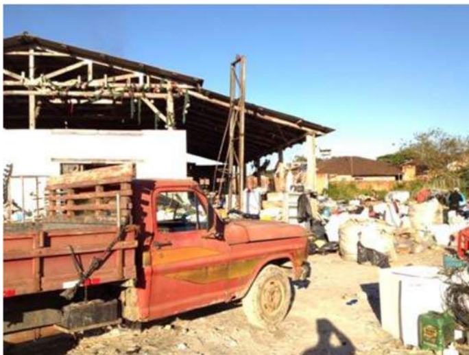
Figura 117: Vista Geral da Unidade de Triagem
