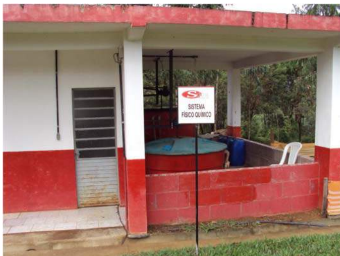
Figura 142: Tratamento Físico-Químico do Chorume
