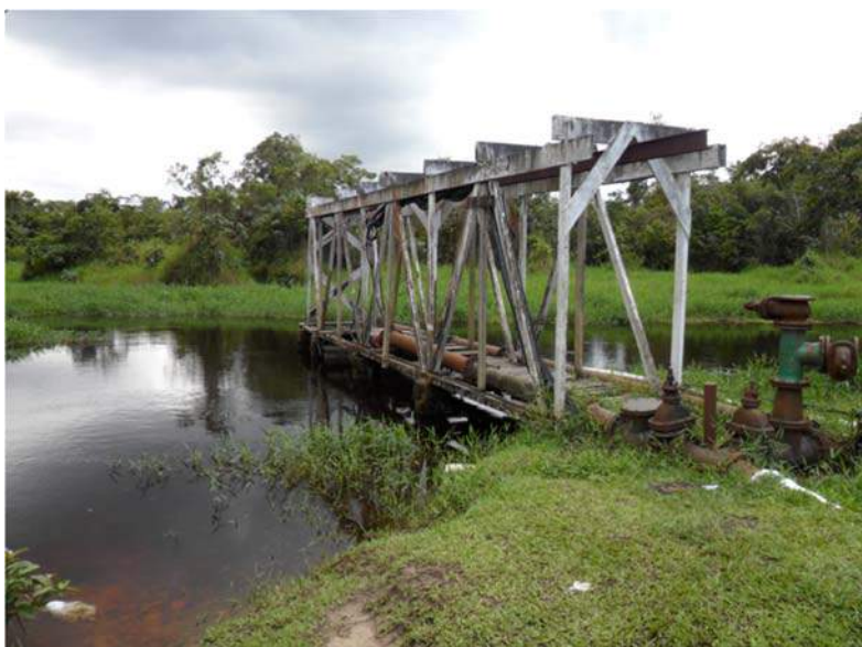
Figura 29: Captação ETA Principal
