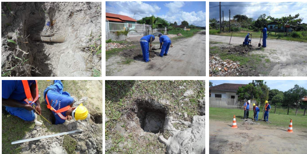
Figura 76: Serviço de Cadastramento das Tubulações Existentes de Adução e Distribuição de Água Tratada
