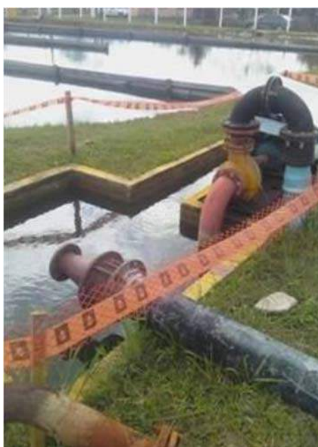
Figura 44: Poço de Recalque da Água Clarificada nas Lagoas de Decantação
