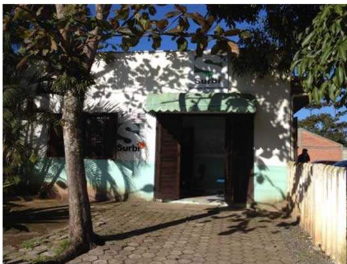
Figura 134: Sede Administrativa (frente)
