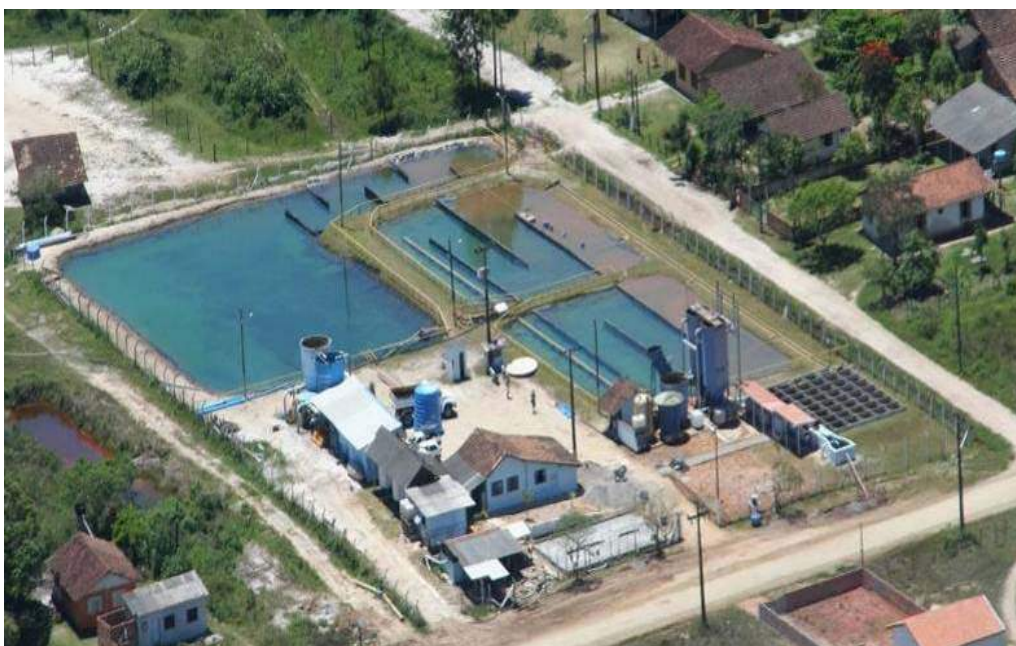
Figura 36: Estação de Tratamento de Água – ETA Principal
